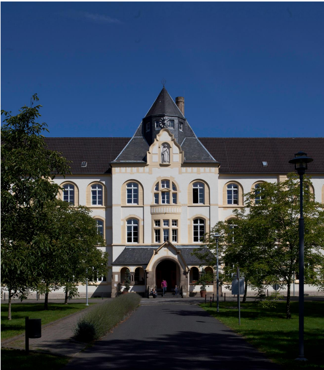
Die markante Fassade im Stil des bergischen Barocks ist Kennzeichen des Alexianer Krankenhauses
